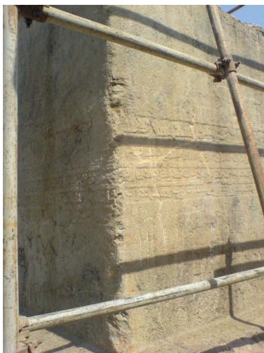
تصویر ۱۷. سنگ نوشته خرم آباد پس از استحکام بخشی با آب آهک و پوشش دهی با پارالوید B72 (نگارندگان).
