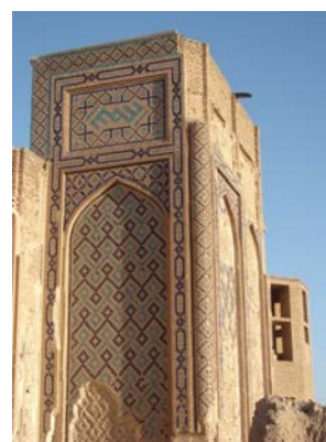
۲۷. تزئینات بدنه بیرونی بادگیر مدرسه غیاثیه. تکنیک این تزئینات مشابه تکنیک تزئینات سایر بخش‌های بدنه بیرونی بناست. ترکیب کاشی و آجر (معقلی) (ماخذ: ذاکرعاملی)
