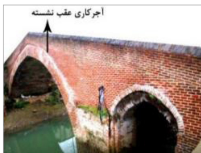
تصویر ۴۱. آجرکاری برجسته، پل خشتی لنگرود. تصویر ۴۲. آجرکاری عقب‌نشسته، پل خشتی نیاکو. تصویر ۴۳. طرح هندسی لوزی آجرکاری، آستانه اشرفیه (قاجاریه) (همان). تصویر ۴۴. پل خشتی تمیجان (صفویه) (همان). (صفویه) (نگارندگان، ۱۴۰۰)
