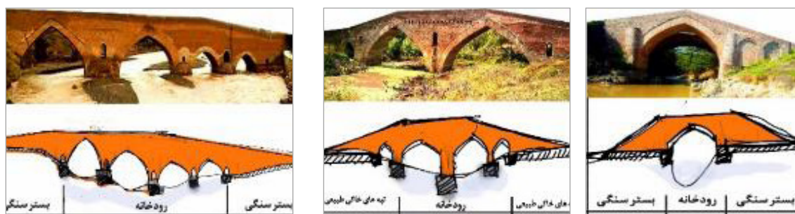
تصویر ۲۰. پی‌سازی کامل پل بر روی بستر سنگی، پل پونل (صفویه) (نگارندگان، ۱۴۰۰) تصویر ۲۱. پی‌سازی کامل پل بر روی بستر خاکی، پل تجن گوکه (صفویه) (همان) تصویر ۲۲. پی‌سازی سنگی در میان رودخانه، پل لوشان (قاجار) (همان)
