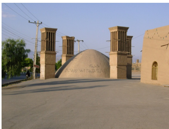
۲۰. آب انبار رستم گیو یزد با بادگیرهای چهارسویه (ماخذ: ذاکرعاملی).
