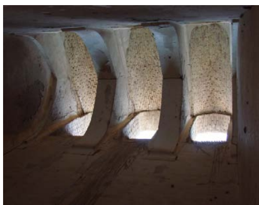
۲۹. تشکیلات سازه چشمه‌های بادگیر مدرسه غیاثیه (ماخذ: ذاکرعاملی)
