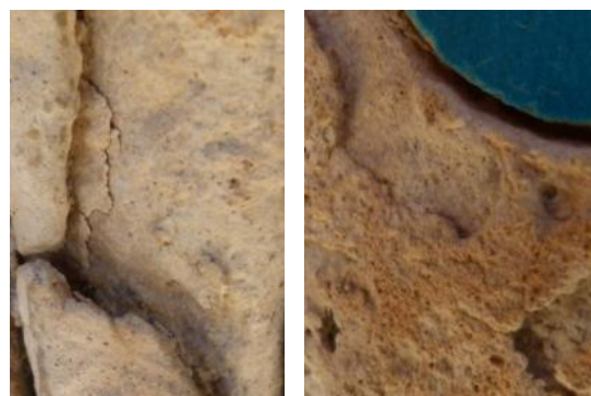
تصویرهای ۱۸-۱۹. پوسیدگی در سطح سنگ کتیبه (نگارندگان).
