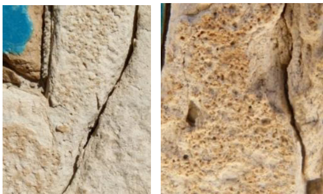
تصویرهای ۲۴-۲۳. وجود ترک در سنگ کتیبه (نگارندگان).
