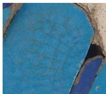
تصویر ۴. وجود ترک شبکه‌ای در سطح لعاب کتیبه (نگارندگان).
