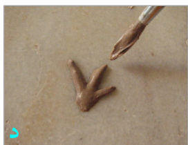
تصویرهای ۲۰-۲۱-۲۲. اجرای مرحله به مرحله نقوش با استفاده از ترکیب حاوی سریش با نسبت یک به پانزده (نگارندگان).
