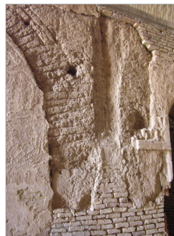
تصویر ۶. شبستان غربی، بخش شمالی جرز F2، جرز خشتی‌چینه‌ای و تویزه خشتی (نگارنده)
