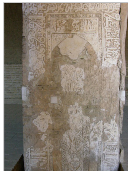
تصویر ۱۱. محراب نمای گچ‌بری بر روی تقویت جرز خشتی توسط آجر در دوره سلجوقی (نگارنده)
