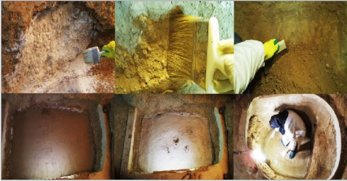
شکل ۱۲، الف. جمع‌آوری خاک کف گور، ب. تثبیت خاک دیواره گورها با شیره آهک و موزون‌سازی رنگی، پ. تثبیت و شفته‌ریزی کف گور با شیره آهک، ت. ملاط‌ریزی کف گور و پوشاندن کف با پلاستیک، ث. گیرش ملاط کف و ج. انجام واکنش شیمیایی پس از ۲۷ شبانه‌روز در گور شماره ۱ (نگارندگان)
